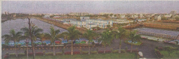
नालों के गंदे पानी के उपचार के लिए कबीटखेड़ी में बनाया गया ट्रीटमेंट प्लांट • नईदुनिया
