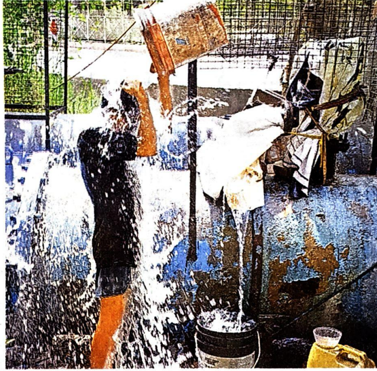
बारापुला फ्लाईओवर के नीचे लोधी रोड शमशान घाट के सामने जल बोर्ड की लीकेज पाइप लाइन से निकलते पानी से नहाता युवक • विपिन शर्मा
