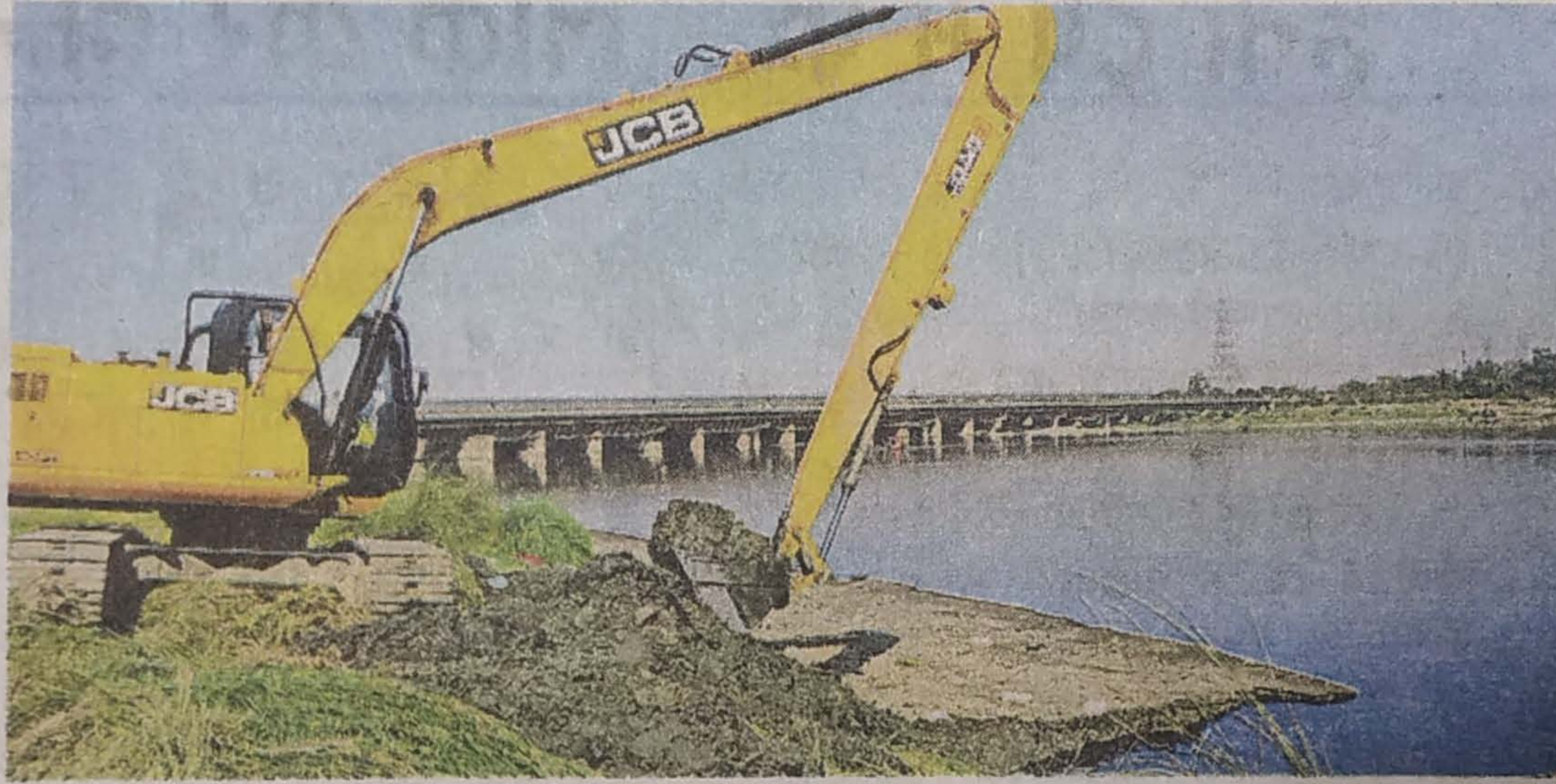
आइटीओ पुल के पास यमुना किनारे से निकाली जा रही सिल्ट • जागरण
